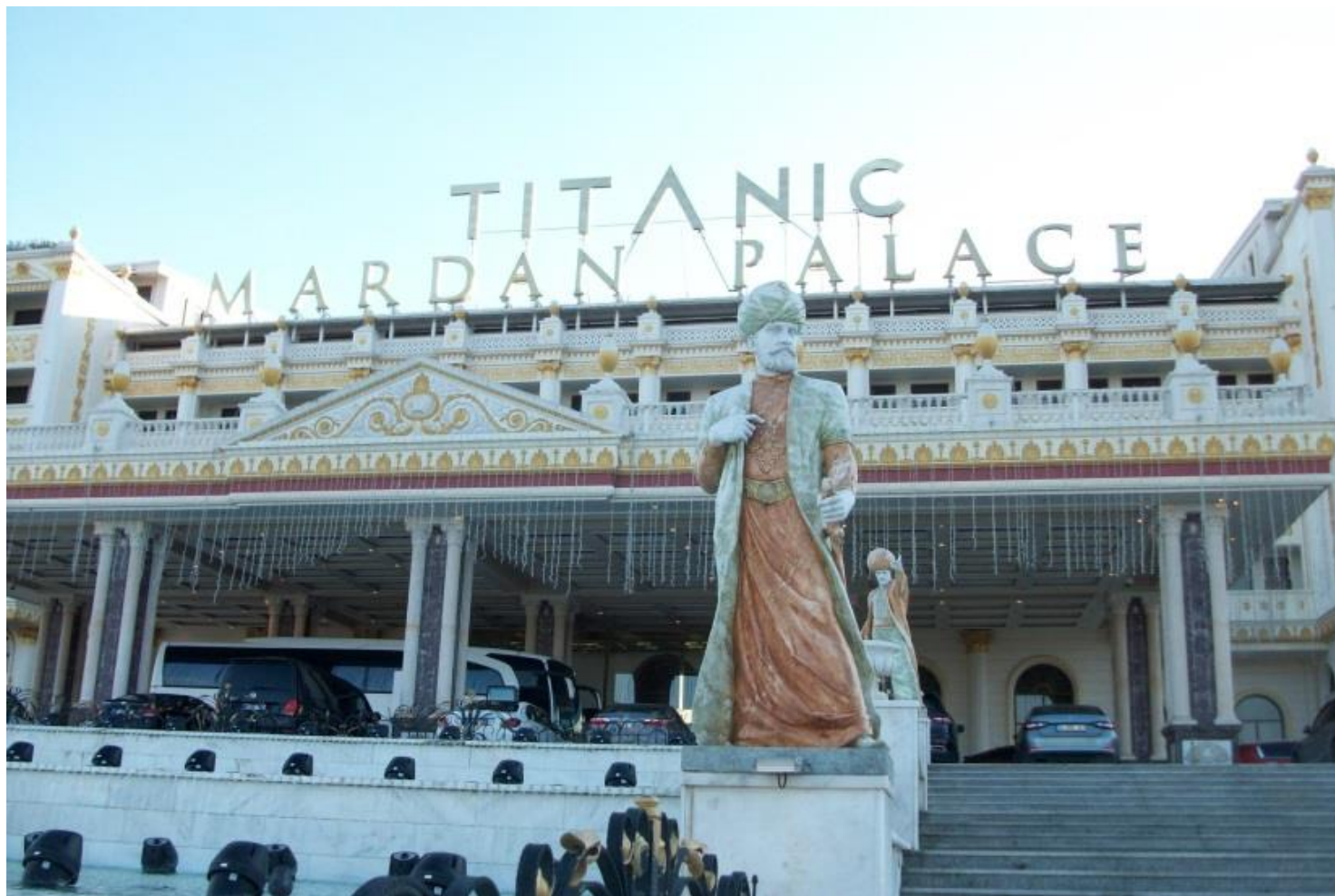
Фрагмент фасада отеля
